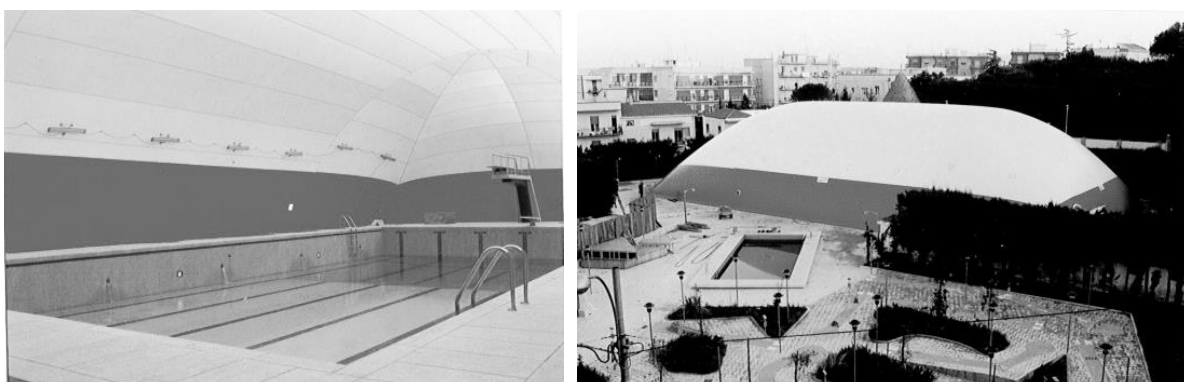
FOTO: Piscina coperta con struttura pressostatica – anno di produzione 1976
